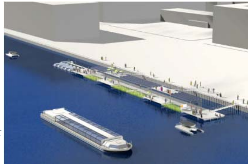
Reduzierung von Notüberläufen in die Gewässer durch Speicherung von Mischwasser direkt im Vorfluter (Quelle: LURI©Sven Flechsenhar)
